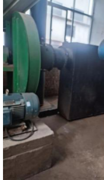
2t/h 蒸汽发生器旋风除尘+水浴除尘
