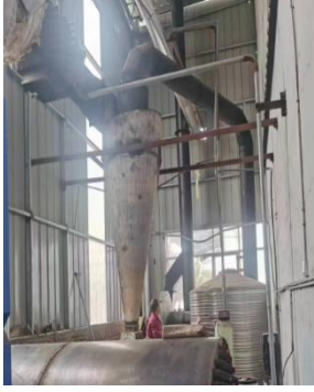
2t/h 蒸汽发生器旋风除尘+水浴除尘
